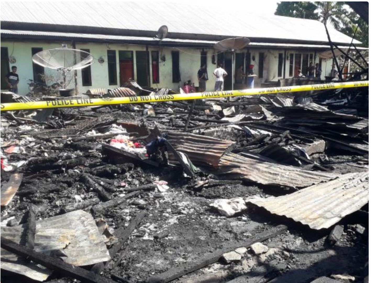
Kondisi terkini pasca kebakaran
